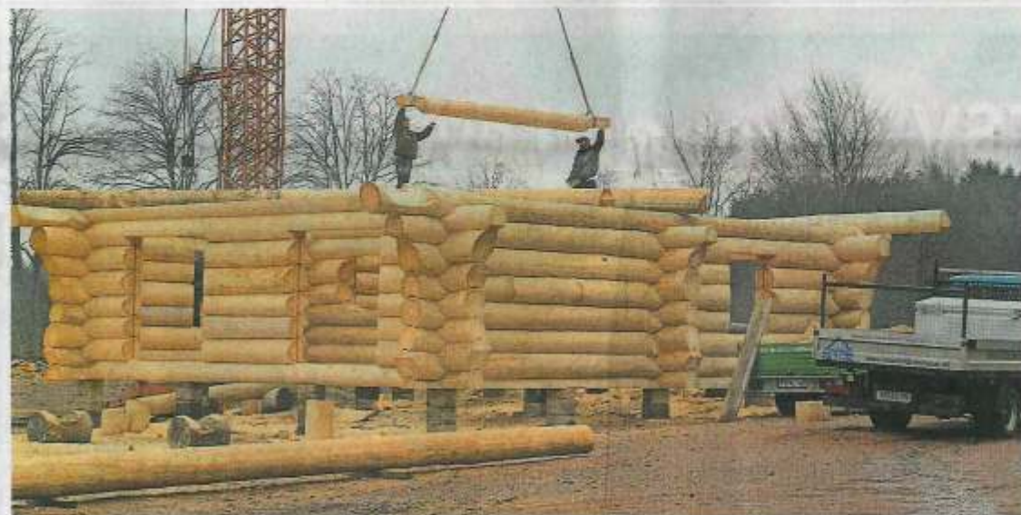
Bevor das Haus in Einzelstämmen seine Reise zum Bauherrn antritt, muss es komplett aufgebaut, und die Stämme müssen durchnummeriert werden.
